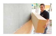
El STEICOprotect L dry es un panel para SATE robusto, con muchas ventajas, incluida la protección térmica. La gran ventaja frente a las fachadas de poliestireno: su alta capacidad de almacenamiento de calor ayuda a combatir el moho. La fachada se enfría más lentamente por la noche, y la humedad del aire no provoca rocío en las paredes exteriores, por lo que el moho no tiene un terreno propicio para su desarrollo.
