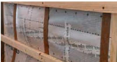
Lors de l'insufflation d'isolant, renforcer la membrane STEICOMulti membra 5 avec STEICOMulti tape
